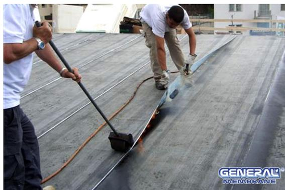
Fig. 13 – Tecnica di giunzione: Rullo (vedere anche la figura del cordolo fuoriuscito da linea di sormonte)
