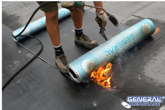
Fig. 12 – Tecnica di giunzione: Piede (vedere anche la figura del cordolo fuoriuscito da linea sormonte)
