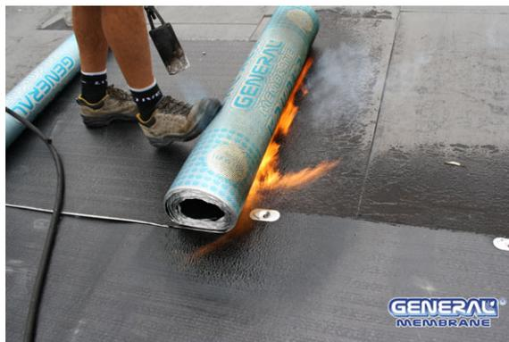
Fig. 4 - posa in totale aderenza su pannello isolante
