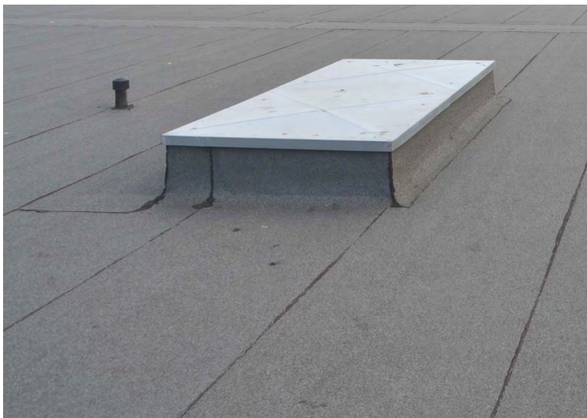
Fig. 37 – Particolare della copertura (oggetto visita ispettiva ITC) realizzata con: GALAXY FC 5,2kg MINERAL
