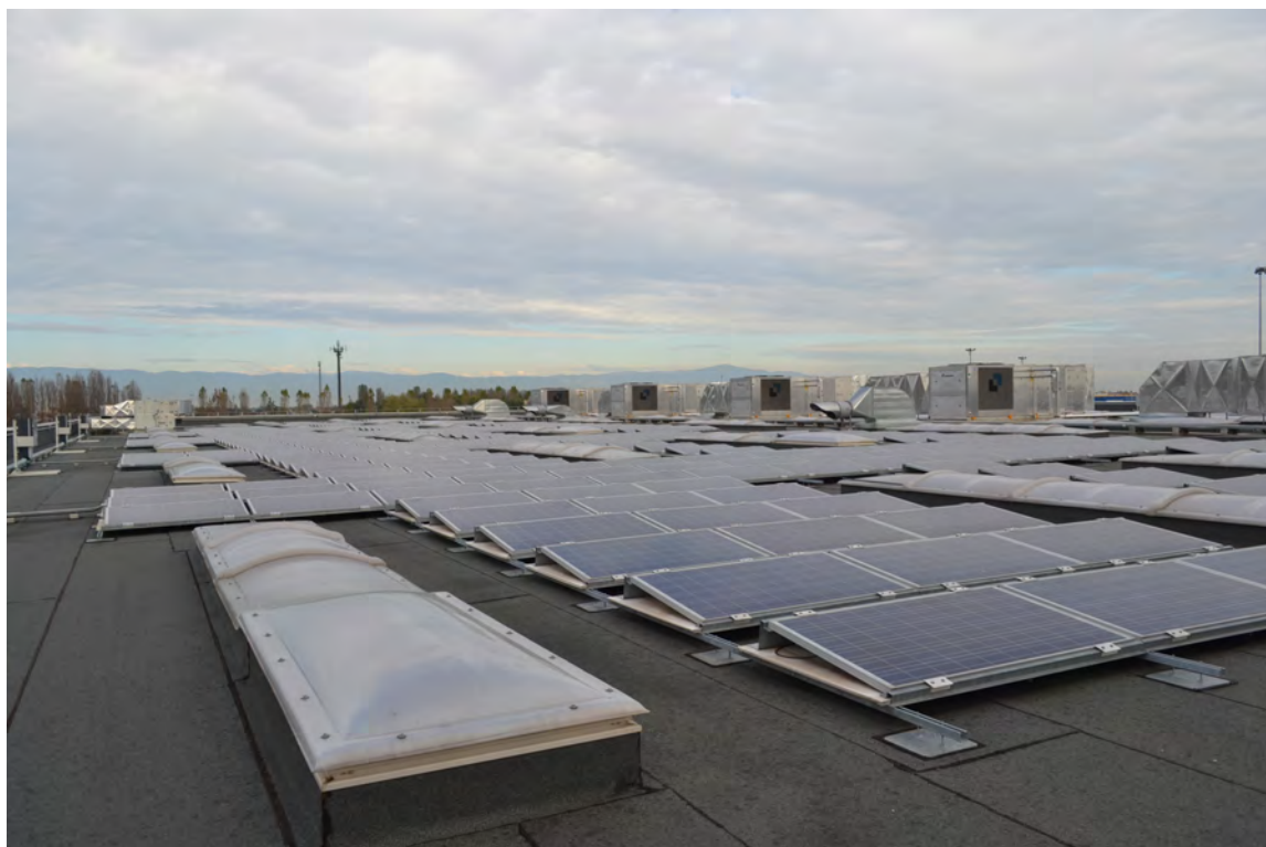
Fig. 36 – Copertura (oggetto visita ispettiva ITC) realizzata con doppio strato: GALAXY FC 5,2 kg MINERAL + URANUS FC 180 4mm
