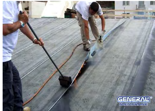
Fig. 12 – Tecnica di giunzione: Rullo (vedere anche la figura del cordolo fuoriuscito da linea di sormonto)
