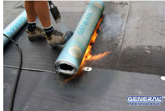
Fig. 3 - posa in totale aderenza su pannello isolante
