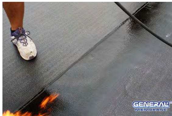
Fig. 13 – cordolo fuoriuscito dalla linea di sormonto
