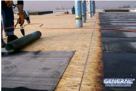
Fig.2 - posa in totale aderenza su supporto ligneo
